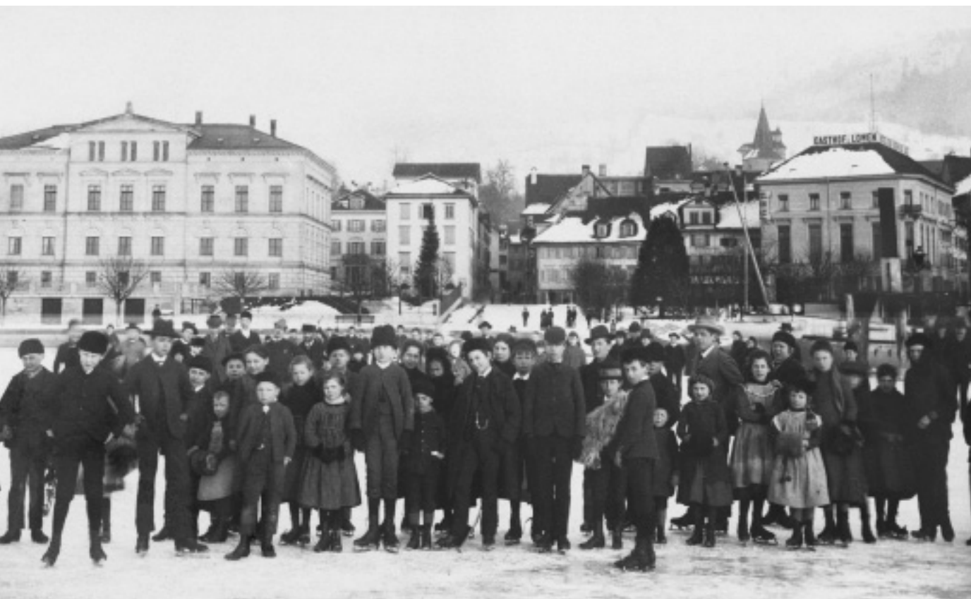
Zuger Seegfrörni 1895: Blick vom See her Richtung Regierungsgebäude und Gasthof Löwen. In der Bildmitte am Ort des heutigen Verwaltungsgebäudes das alte Stadttheater.
